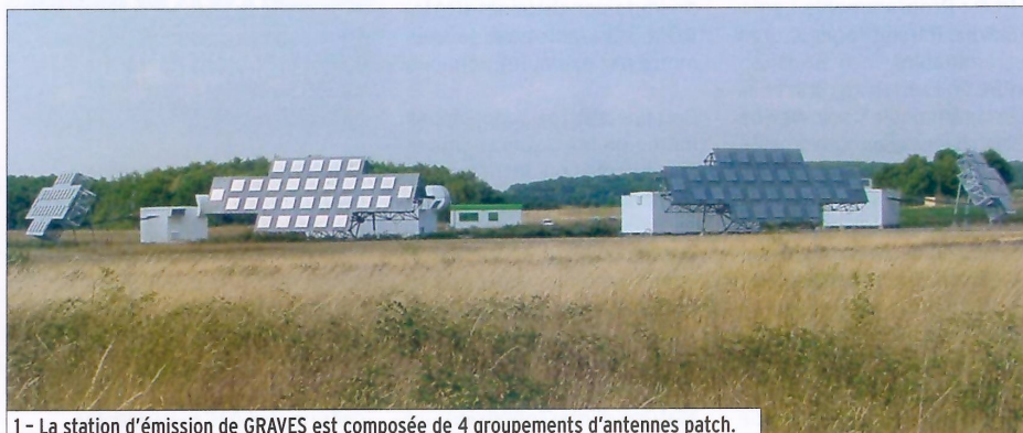
1 - La station d'émission de GRAVES est composée de 4 groupements d'antennes patch.
